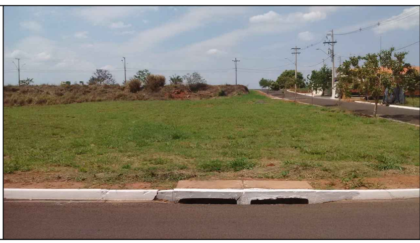
Foto 01: Vista do terreno pela Rua João Fernandes com boca de lobo dupla na frente do terreno.
